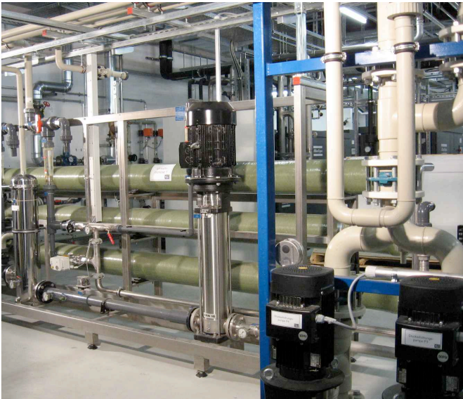
Bosch AG, Abstadt: Umkehrosmose mit Konzentrataufbereitung
